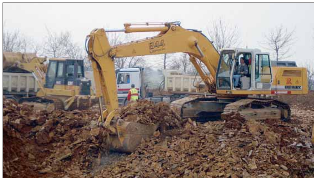
Les travaux vont bon train.
